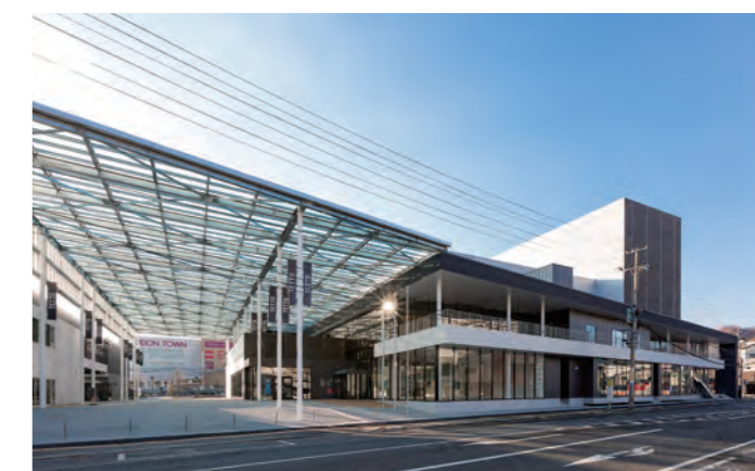
岩手県 / 釜石市民ホール TETTO MS2500・PU9000typeNB
